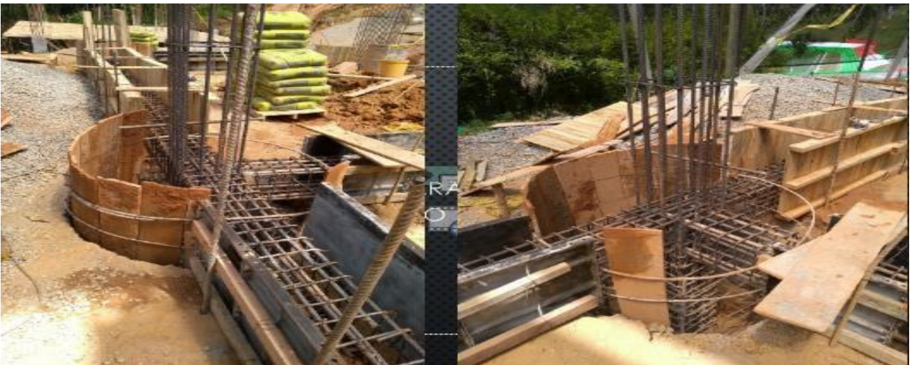
Figurado y Armado de refuerzo –vigas de fundación y pedestales – torre 2 – norte = 5250 KGS
