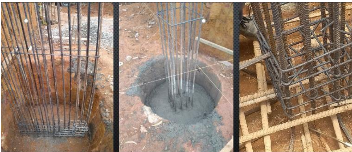
VACIADO DE PEDESTALES – TRANSICION DE PILAS A COLUMNAS 37.4 M3
